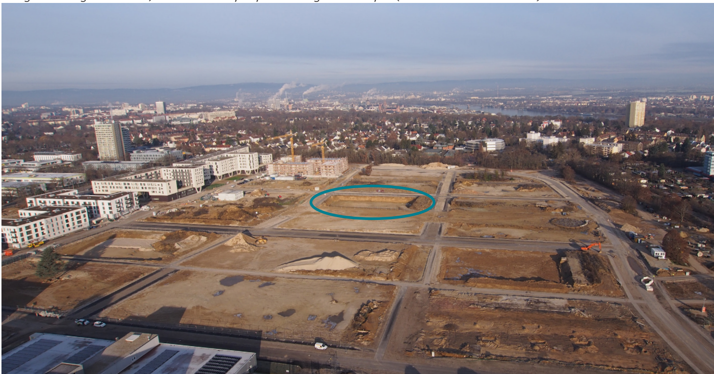
Baugebiet Heiligkreuz-Viertel, reserviertes Baufeld für drei Baugemeinschaften (Foto:Mainzer Stadtwerke AG)
