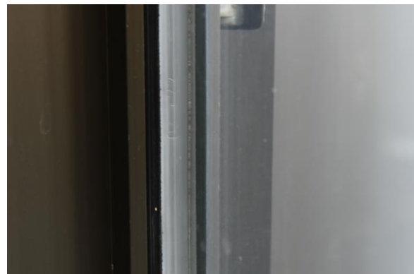
Abb. 2.1.94 Thermopane Zweischeiben-Isolierverglasung, Prägestempel 04 / 72, Foto: strebewerk. 2018
