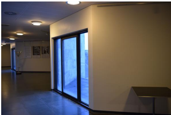
Abb. 2.1.81 Dachgeschoss, Glasschiebetüren zu den Austritten, Foto: strebewerk. 2018
