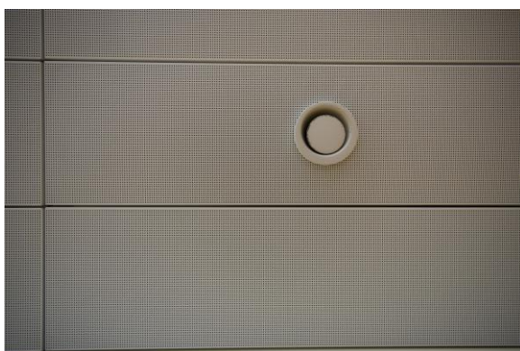
Abb. 2.1.01 Langrechteckiges Deckenpaneel in Weiß mit Abluftglocke, Flur Erdgeschoss, Foto: strebewerk. 2018
