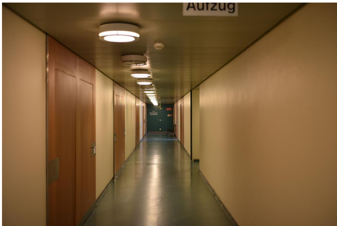
Abb. 2.2.14 Exemplarischer Flurabschnitt im Verwaltungsgeschoss, Bodenbelag Linoleum, Deckenpaneele grau, Foto: strebewerk. 2018
