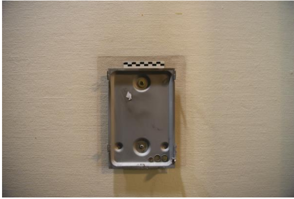
Abb. 2.1.37 Flur, grob texturierte PVC-Tapete auf Gipskartonbeplankung, unter dem ehem. fest installierten Objekt hat sich die bauzeitliche Farbigekeit erhalten, Foto: strebewerk. 2018
