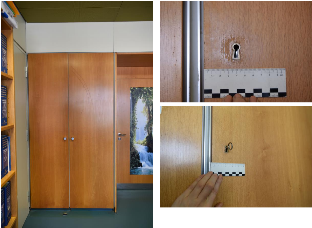
Abb. 2.2.07, 2.2.08 und 2.2.09 Links: Einbauschränk mit nachträglich eingebautem Drehgriff, rechts: bauzeitliches Schloss mit Metalleinfassung und Schlüssel, Foto: strebewerk. 2018
