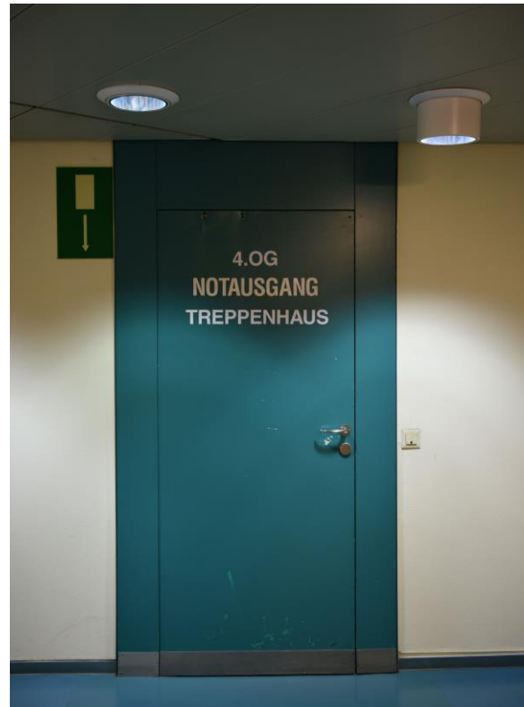
Abb. 2.1.64 Treppenhaus, Fluchttür, Foto: strebewerk. 2018
