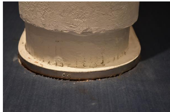
Abb. 2.1.47 Auditorium, eingestellte Trennwand mit Schattenfuge im Sockelbereich, Foto: strebewerk. 2018
