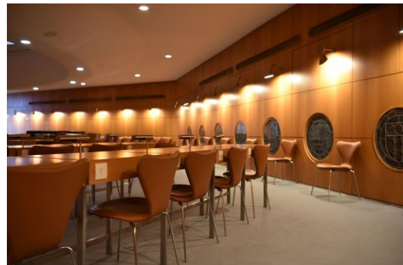
Abb. 2.1.139 Ratssaal, Lüftungselemente in Täfer integriert, abgerundete Ecken, Foto: strebewerk. 2018
