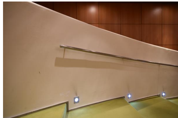
Abb. 2.1.45 Auditorium, Brüstungswand mit Glattputz und weißem Anstrich, Foto: strebewerk. 2018
