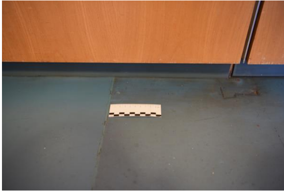
Abb. 2.1.23 Büro, Stoß von bauzeitlichem Linoleum und Ersatz, Foto: streberwerk. 2018
