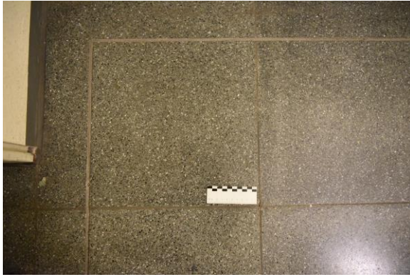
Abb. 2.1.29 Treppenhaus, Betonwerksteinplatten auf dem Treppenpodest, Foto: strebewerk. 2018
