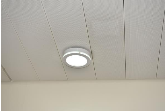
Abb. 2.1.03 Flur, weiße Deckenpaneele, Foto: strebewerk. 2018
