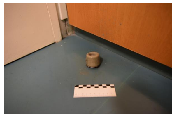
Abb. 2.1.61 und 2.1.62 Treppenhaustür, Türschließer und Bürotür, Türstopper, Foto: strebewerk. 2018
