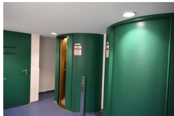
Abb. 2.1.70 3. Untergeschoss, Tür zur Tiefgarage, Foto: strebewerk. 2018
