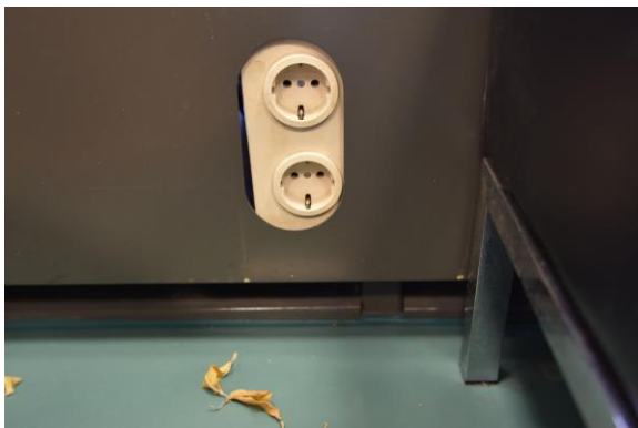
Abb. 2.1.126 Steckdose in Klimaelement integriert, Foto: strebewerk. 2018
