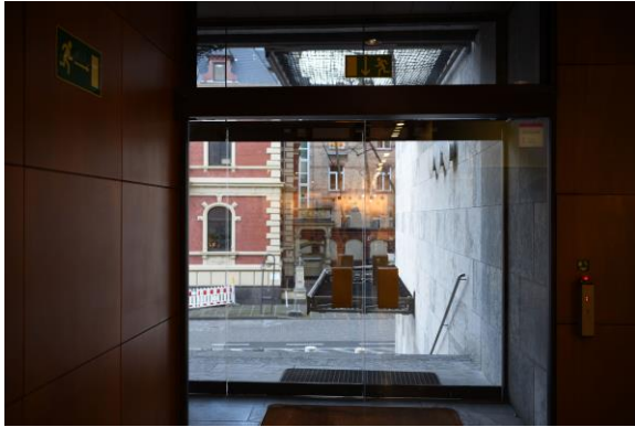
Abb. 2.1.85 Haupteingangstür von innen, Foto: strebewerk. 2018
