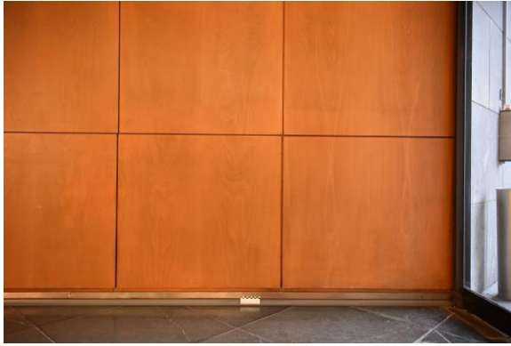
Abb. 2.1.42 Wandtäfer, gedämpfte Buche, einfache Fugen ohne Deckleisten, verdeckte Befestigung, Stahlkante als Überleitung zum Bodenbelag, Foto: strebewerk. 2018
