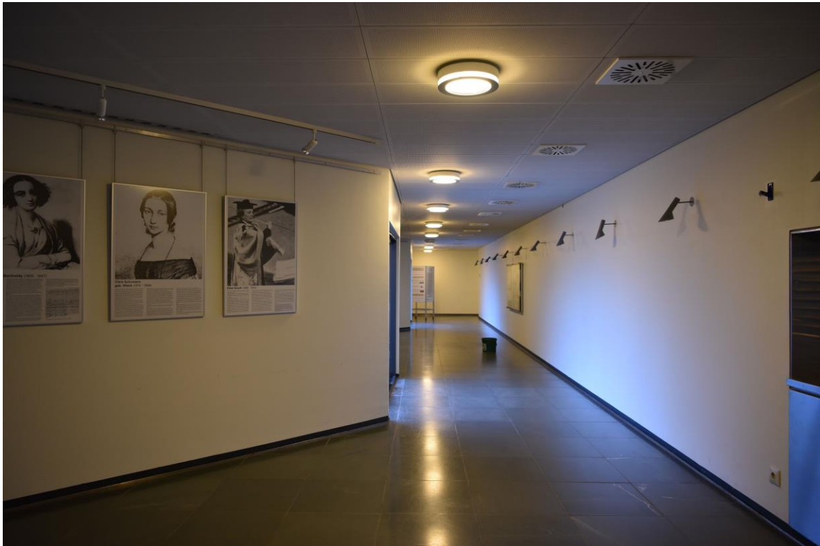
Abb. 2.2.12 Flur im Bereich der ehem. Cafeteria, Dachgeschoss, Foto: strebewerk. 2018
