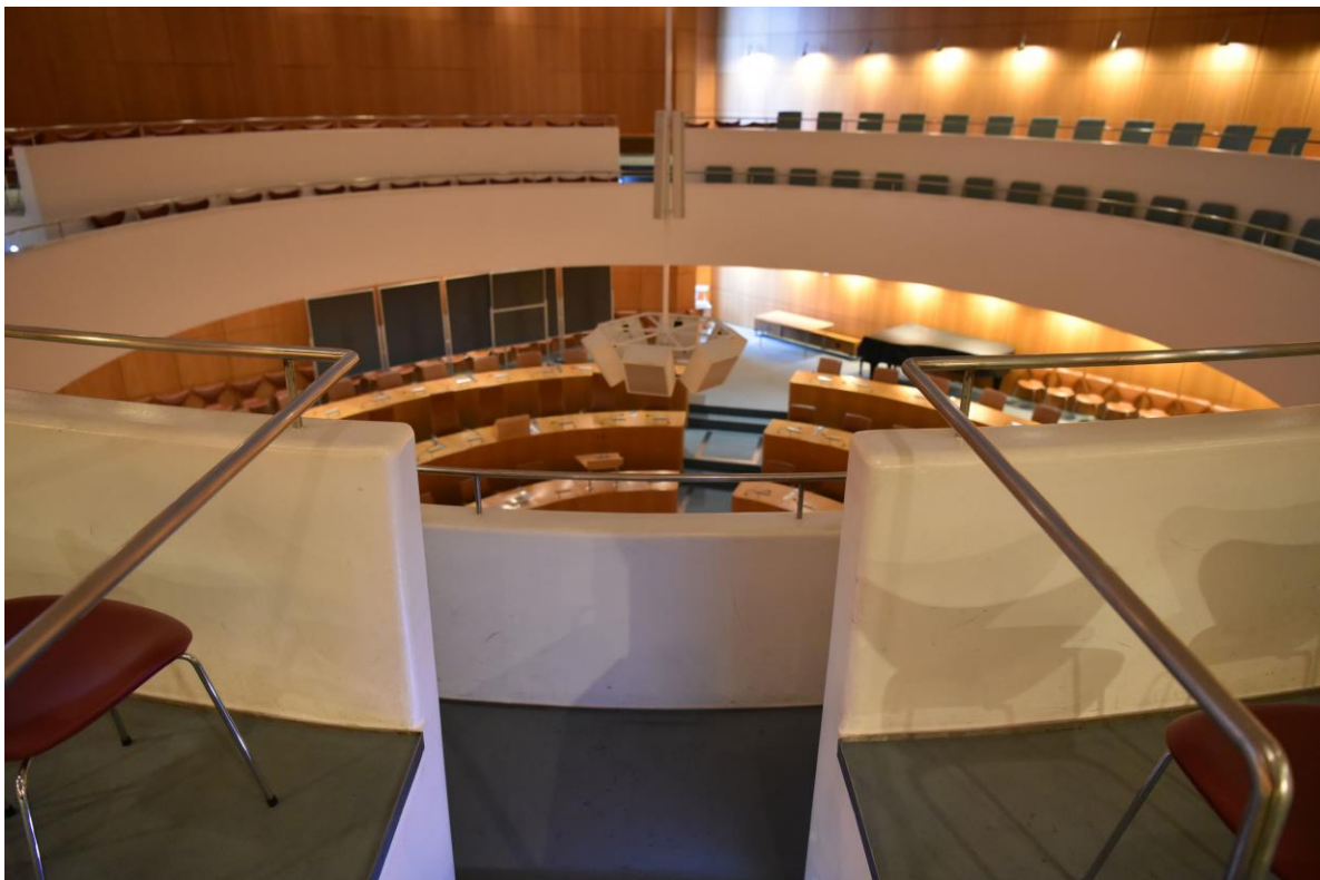
Abb. 1.2.23 Ratssaal, runde Brüstungswände mit aufgesetzten Handläufen aus poliertem Edelstahl, Foto: strebewerk. 2018
