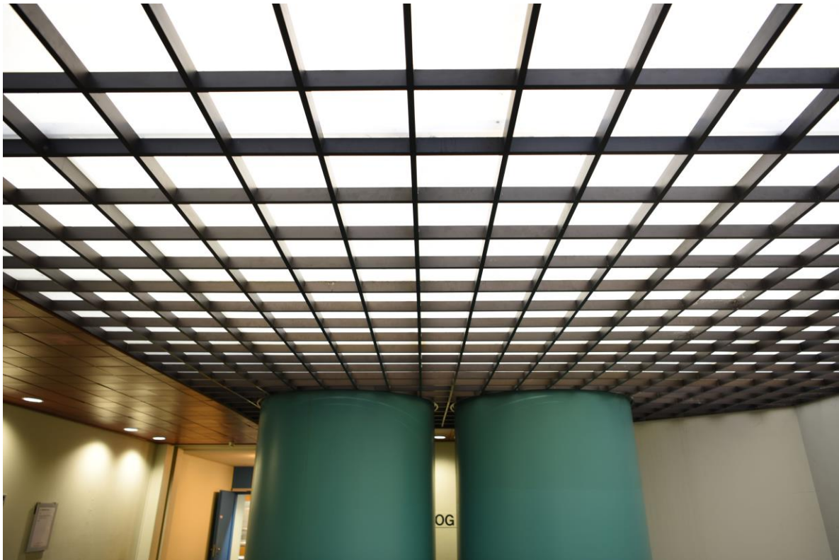
Abb. 1.2.04 Glasdach als Lichtdecke in der Eingangshalle, Foto: strebewerk. 2018
