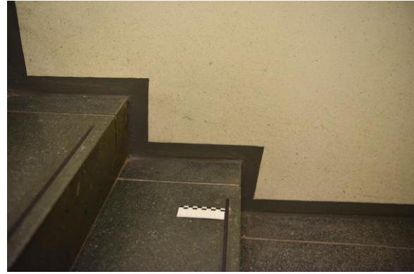
Abb. 2.1.30 Treppenhaus, Betonwerksteinwinkelstufen, Foto: strebewerk. 2018
