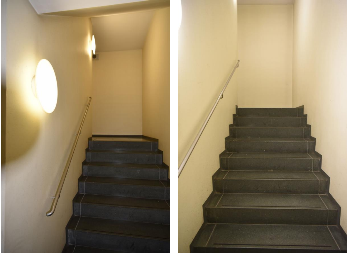
Abb. 2.2.10 und 2.2.11 Blick in ein exemplarisches Geschoss des Fluchttreppenhauses mit Beleuchtung, Treppenstufen aus Betonwerkstein und Wandgestaltung, Foto: strebewerk. 2018
