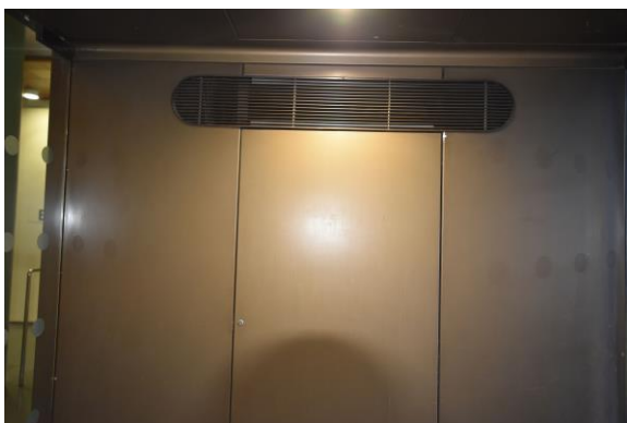
Abb. 2.1.140 Haupteingang, Lüftungsgitter in Wandbekleidung integriert, abgerundete Ecken, Foto: strebewerk. 2018
