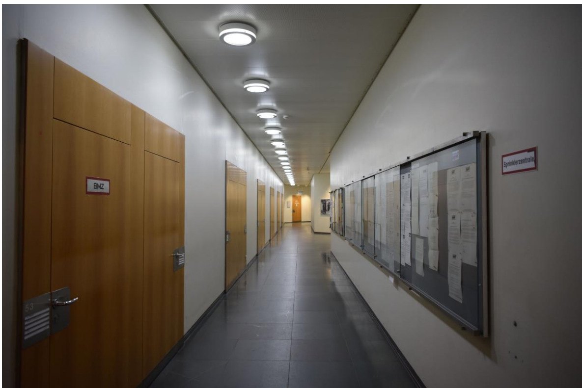
Abb. 2.2.13 Exemplarischer Flurabschnitt im Erdgeschoss vor den Fraktionsbüros, Bodenbelag aus Natursteinplatten, Deckenpaneele weiß, Foto: strebewerk. 2018
