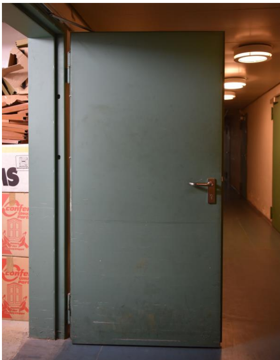
Abb. 2.1.83 Kellertür aus Stahlblech, Foto: strebewerk. 2018
