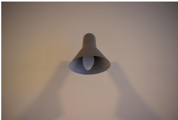
Abb. 2.1.97 und 2.1.98 5. Obergeschoss, Wandleuchte, Foto: strebewerk. 2018
