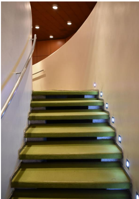
Abb. 1.2.16 und 1.2.17 Auditorium, Treppe mit Stahlblechstufen, wandintegrierter Beleuchtung und Edelstahlhandlauf (links) und eingestellte Wandscheibe im Vorbereich des Auditoriums, Foto: strebewerk. 2018
