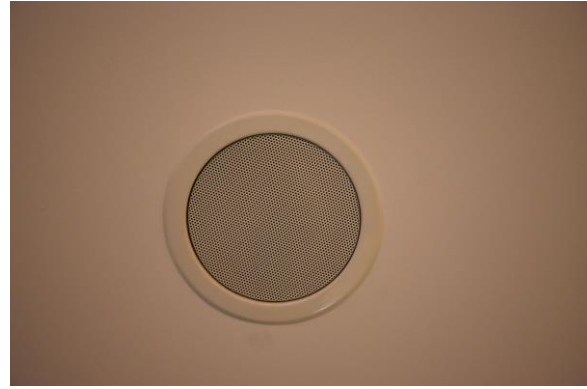
Abb. 2.1.123 Ratssaal, Deckenlautsprecher in Rabiitzdecke integriert, Foto: strebewerk. 2018
