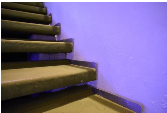
Abb. 2.1.33 Auditorium, Treppenstufen aus gekantetem Stahlblech mit Teppichbelag, Foto: strebewerk. 2018
