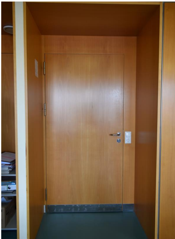
Abb. 2.1.60 Bürotür, Innenseite, Foto: strebewerk. 2018
