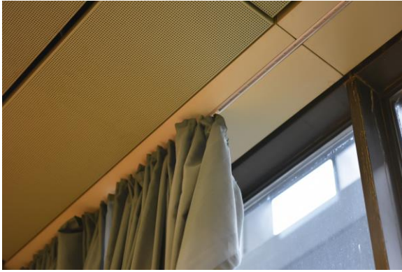
Abb. 2.1.89 Empfangsraum, Vorhangschiene mit bauzeitlichem Vorhang, Foto: strebewerk. 2018
