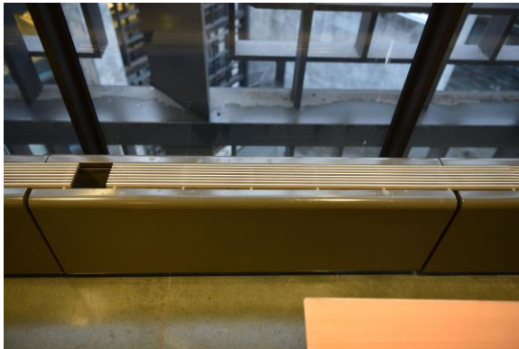
Abb. 2.1.132 Sitzungssaal, Klimatelement, Foto: strebewerk. 2018
