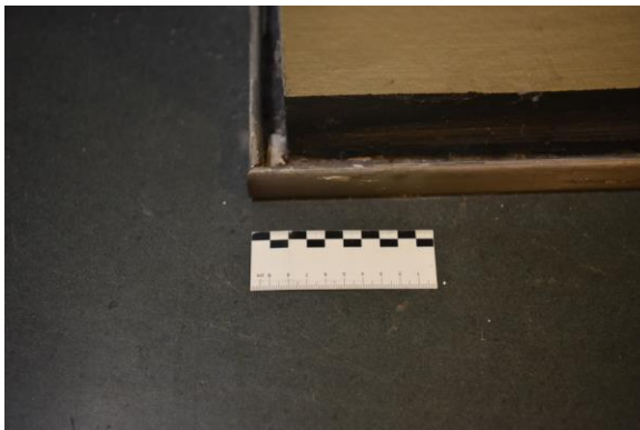
Abb. 2.1.19 Eingangshalle, Galerie, Linoleumbelag mit vorgelagerter Stahlkante und rückspringender Sockelzone, Foto: strebewerk. 2018
