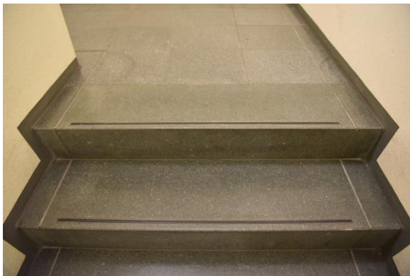
Abb. 2.1.31 Treppenhaus, Betonwerksteinwinkelstufen mit eingefräster Nut, Foto: strebewerk. 2018
