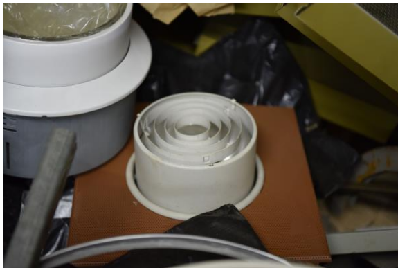
Abb. 2.1.109 Materiallager, Deckenlampe, Foto: strebewerk. 2018
