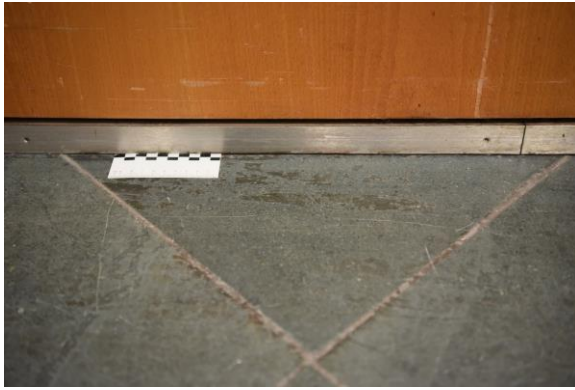
Abb. 2.1.17 Bodenbelag aus Naturstein, Stahlsockelleiste, Täfer, Foto: strebewerk. 2018
