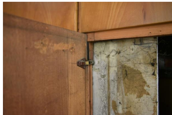
Abb. 2.1.150 Originales Band der Täfertür, Foto: strebewerk. 2018
