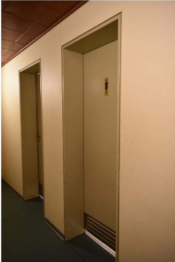
Abb. 2.1.75 Erschließungs-/Sanitärkern, Toilettentüren, Foto: strebewerk. 2018
