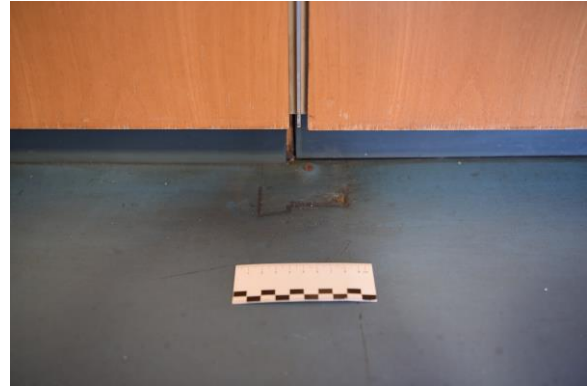
Abb. 2.1.24 Abdruck eines ehem. Standortes einer Modulwand, Foto: streberwerk. 2018
