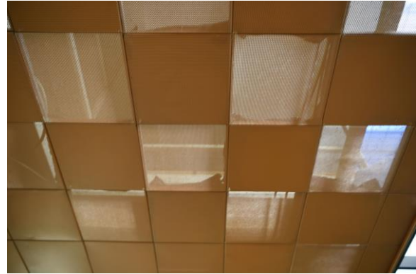
Abb. 2.1.04 Eingangshalle, rote quadratischen Deckenplatten mit Auflage, Foto: strebewerk. 2018
