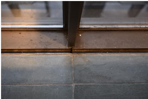
Abb. 2.1.87 Fensterrahmen, Foto: strebewerk. 2018
