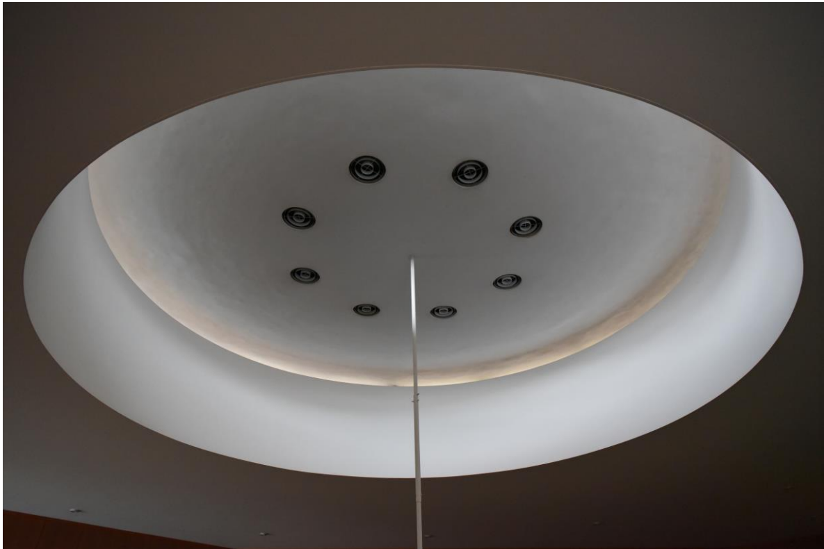
Abb. 1.2.20 Ratssaal, runde Laterne, Rabitzkonstruktion, Foto: strebewerk. 2018
