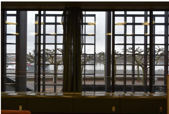
Abb. 2.1.91 Fensterelement mit vorgesetztem Sonnenschutz, Foto: strebewerk. 2018
