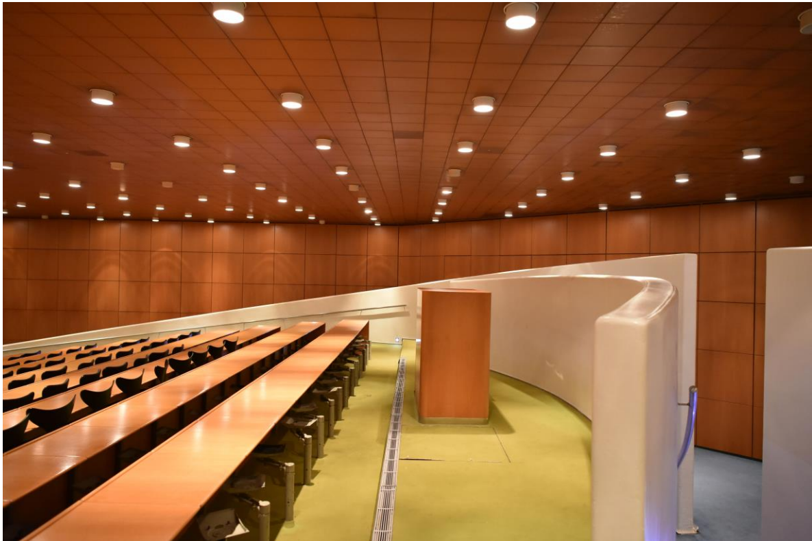
Abb. 1.2.15 Auditorium mit Technikpult und runden Umfassungswänden, bauzeitlicher Teppich, Lüftungsschlitze im Boden, Foto: strebewerk. 2018
