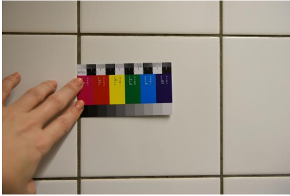
Abb. 2.1.48 Sanitärräume, weiße, quadratische Wandfliesen, Foto: strebewerk. 2018
