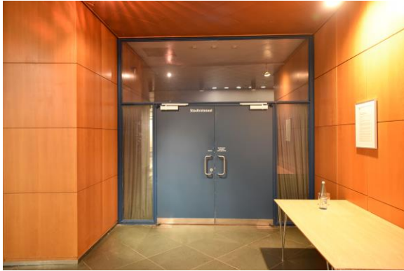
Abb. 2.1.79 Stahl-Glas-Element, Zugangstür zum Ratssaal im Erdgeschoss, Foto: strebewerk. 2018
