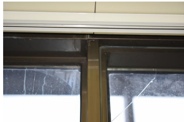
Abb. 2.1.92 Fensterelement mit eingesetztem zusätzlichem Rahmen, Foto: strebewerk. 2018
