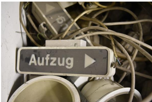
Abb. 2.1.159 Ausgebaute Hinweisleuchten, Foto: strebewerk. 2018
