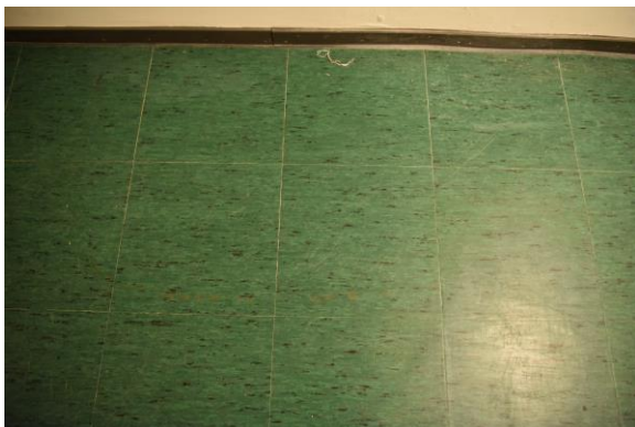
Abb. 2.1.27 Untergeschoss, grün maserierte PVC-Platten, Foto: streberwerk. 2018
