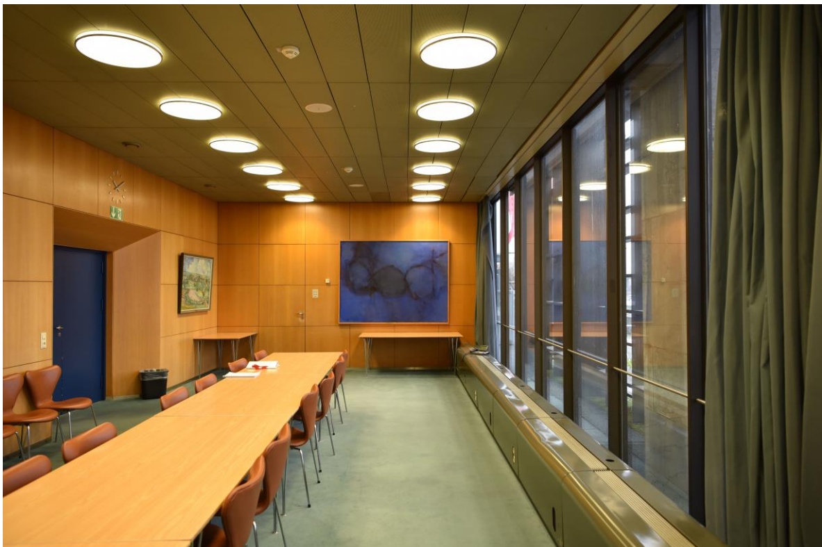
Abb. 1.2.32 Empfangsraum, bauzeitliche Ausstattung mit Klimatelementen, abgehängter Decke, Teppich und Vorhängen, Foto: strebewerk. 2018
