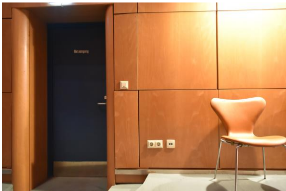
Abb. 2.1.65 Ratssaal, Galerie, Tür zum Notausgang mit abgerundeten Laibungskanten, Foto: strebewerk. 2018
