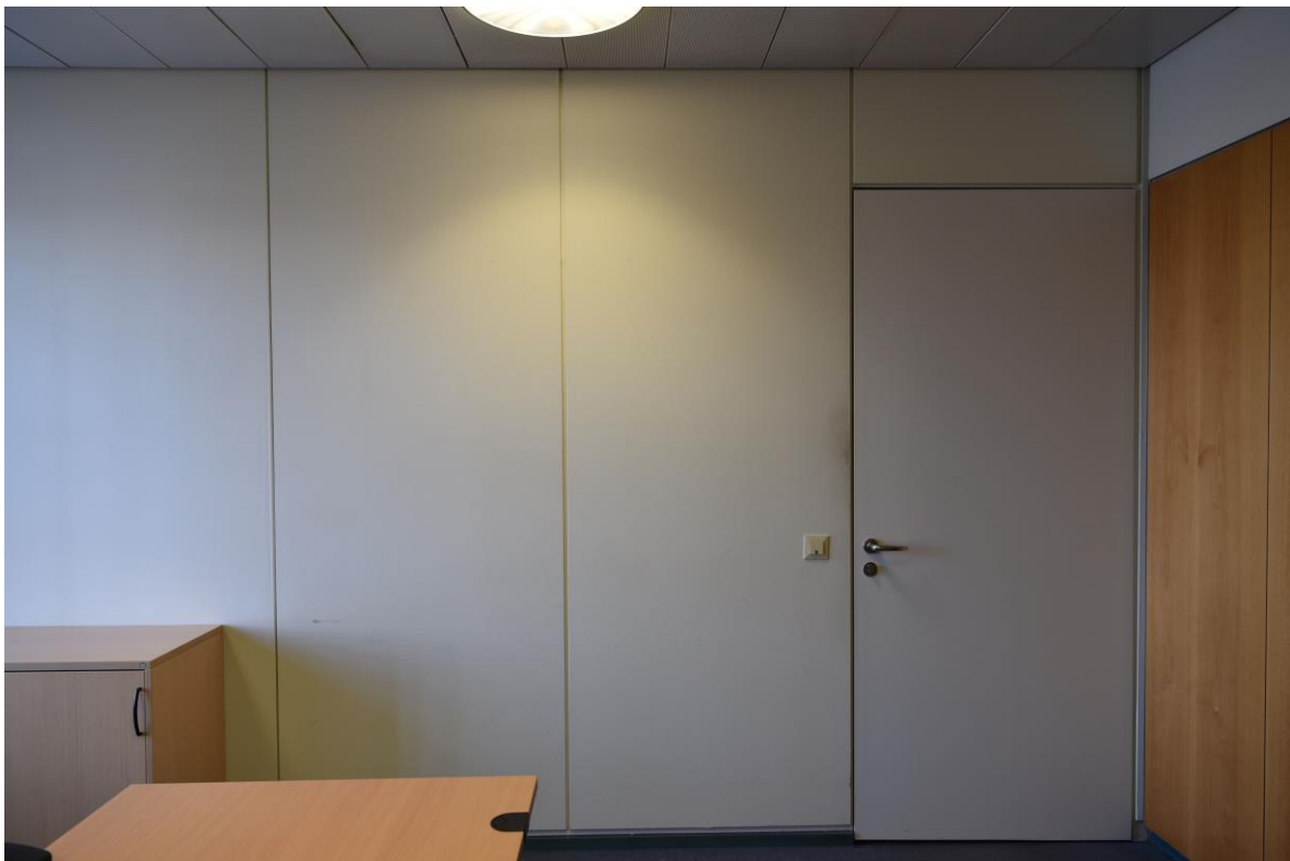
Abb. 2.2.06 Exemplarischer Büroraum, Frontalansicht Modulwand mit bauzeitlicher Sockelleiste und Lichtschalter, Foto: strebewerk. 2018
