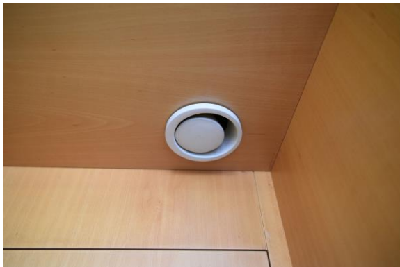
Abb. 2.1.138 Büroraum, Türlaibung, Abluftglocke, Foto: strebewerk. 2018
