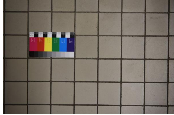
Abb. 2.1.36 Sanitärräume, kleinformatische, graue Bodenfliesen, Foto: strebewerk. 2018
