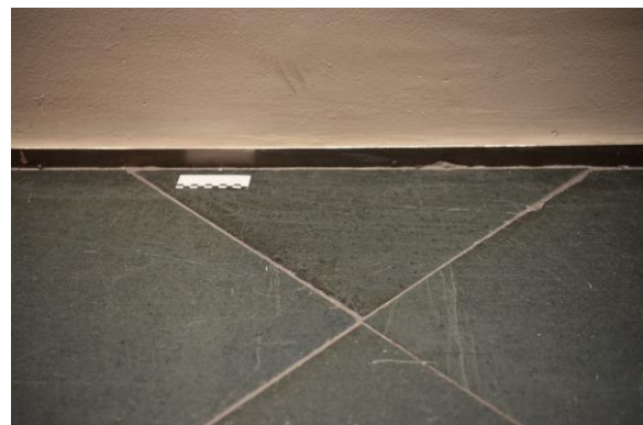
Abb. 2.1.16 Flur, diagonal verlegte Bodenplatten aus Naturstein, Foto: strebewerk. 2018
