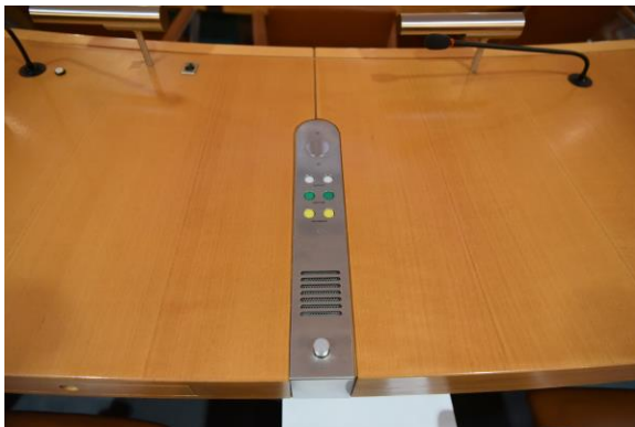
Abb. 2.1.117 Ratssaal, Mikrofon- und Beleuchtungs-Schaltpult in Tischplatte integriert, Foto: strebewerk. 2018
