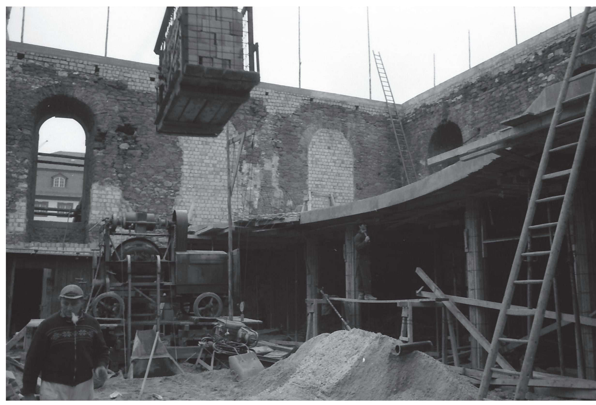
Umbau der ehemaligen Reithalle des Kurfürstlichen Marstalls zur „Steinhalle“ während des Wiederaufbaus der Golden-Ross-Kaserne, 1961. (Fotografin: Karin Eckert) Quelle: Stadtarchiv Mainz
