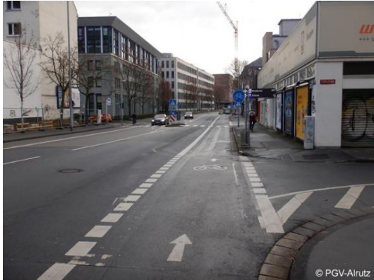
Abb. 3-14: Breiter Radfahrstreifen Bauhofstraße in der zentralen Achse zwischen Neustadt und Altstadt
