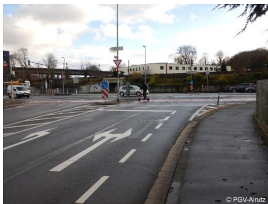
Abb. 3-18: Aufgeweiteter Radaufstellstreifen mit zuführendem Schutzstreifen am südlichen Ende der Hauptstraße in Mombach
