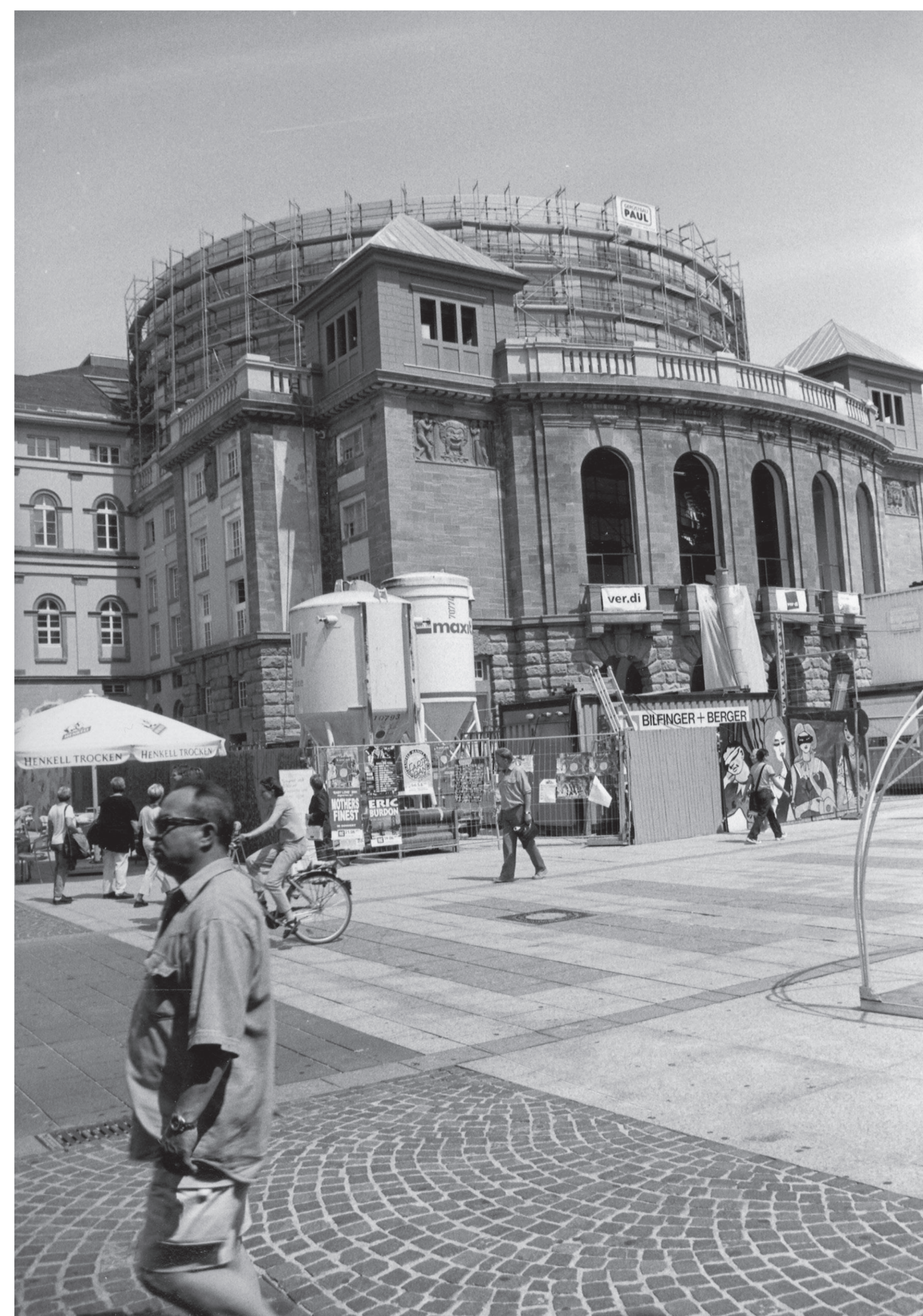
Umbaumaßnahmen am „Großen Haus“ des Staatstheaters Mainz und Errichtung der Glaskuppel auf dem Dach, 15. Juni 2001. (Fotograf: Dieter Schreiber) Quelle: Stadtarchiv Mainz
