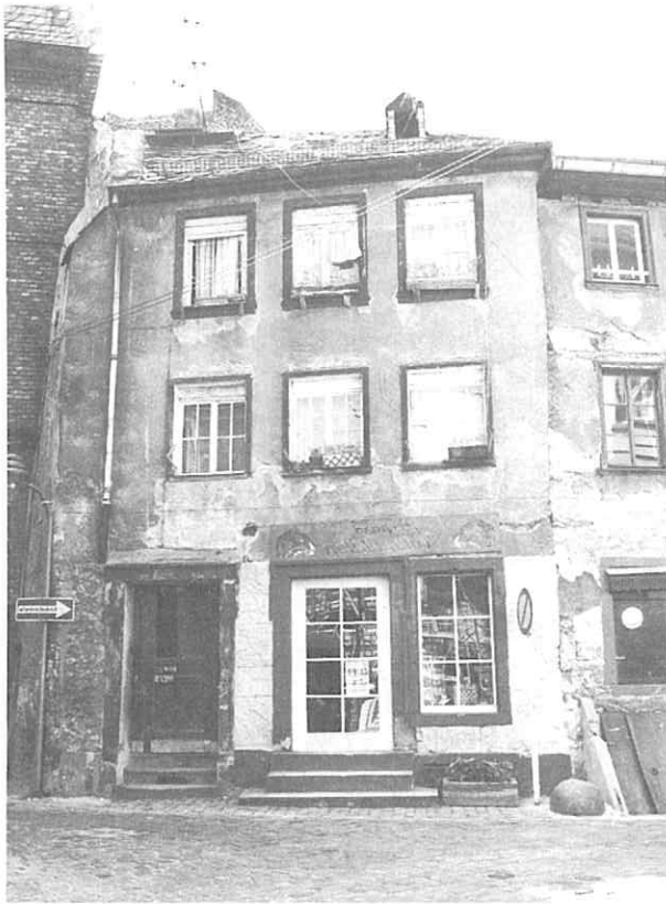
Objekt vor der Sanierung
