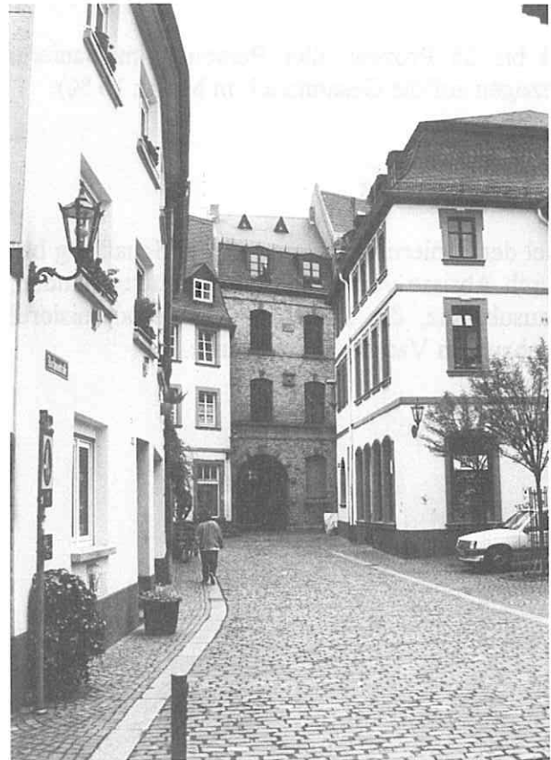
Straßenflucht nach der Sanierung
