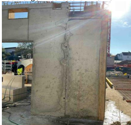
Abbildung 11: Fehlende Rüttelgasse
