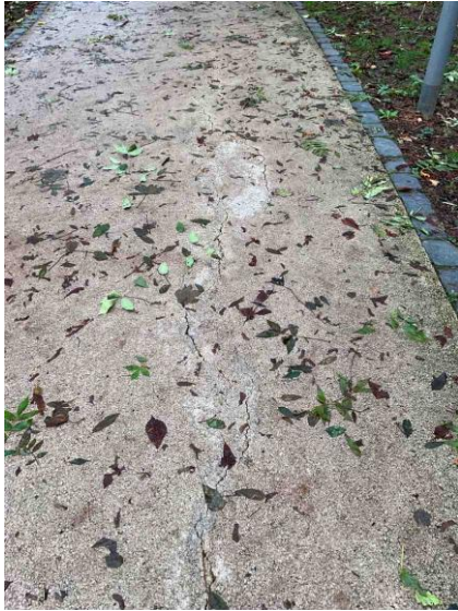
Abbildung 13: Gefärbte Asphaltoberfläche mit vergessenen Rissen, die wieder durchgeschlagen sind
