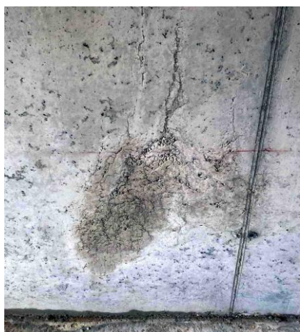
Abbildung 9: Kiesnester und Lunker
