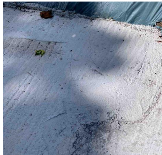
Abbildung 8: Riss und entmischte Betonoberfläche vom Fundament
