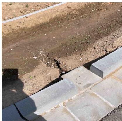
Abbildung 3: Ausgespülter Muldeneinlauf
