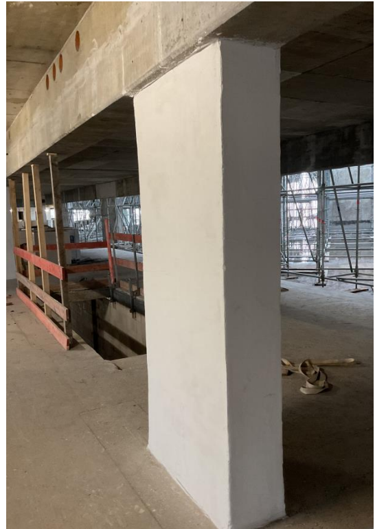
Abbildung 24: Betonsanierung Innenstütze
