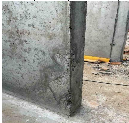
Abbildung 12: Abgeplatzte Ecken
