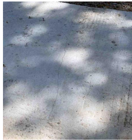
Abbildung 6: Riss auf der Oberfläche vom Fundament für die Stützwand
