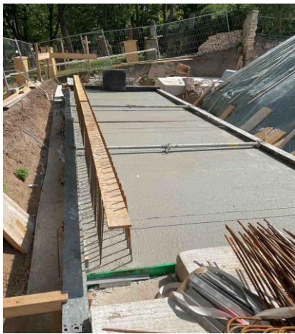
Abbildung 5: Fertig betonierte Fundament unter Sonneneinstrahlung
