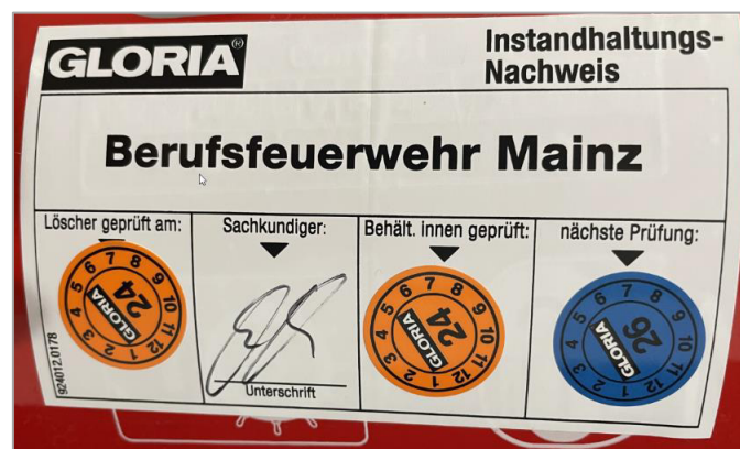
Bild 5: Prüfplakette auf einem Feuerlöscher
