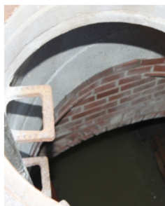
Kanalschacht in Klinkersteinen und Beton
