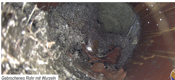
Rohr komplett mit Wurzeln verstopft
