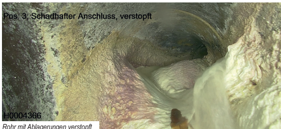
Rohr mit Ablagerungen verstopft
