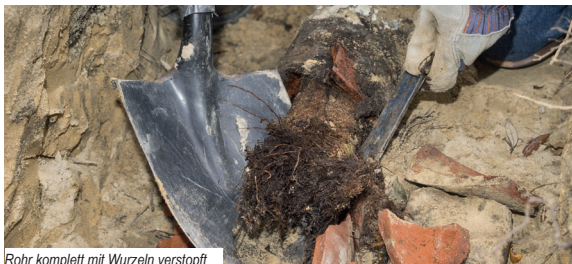
Rohr komplett mit Wurzeln verstopft
