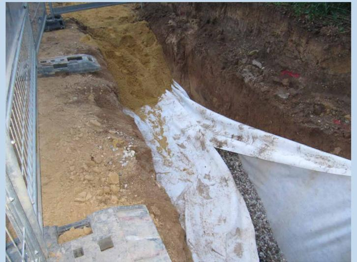
Dieser wird mit einem wasserdurchlässigen Vlies ausgekleidet und mit grobem Kies befüllt.
