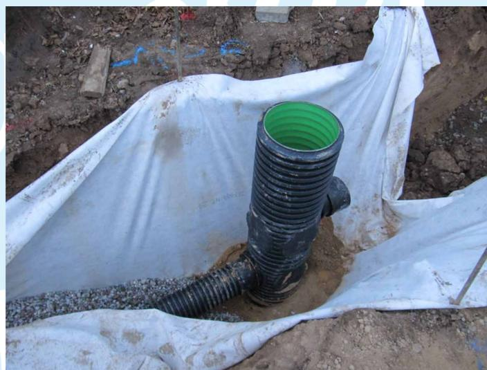
Damit die Rigolen das Wasser besser verteilen können, werden geschlitzte Filterrohre in den Kies gelegt.
