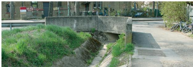
*Im unteren Bereich am alten Wasserwerk, Militärstraße ist der Entwässerungsgraben befestigt. Von links aus Süden entwässert der Zufluss aus Ebersheim kommend. Mit den o.g. Maßnahmen würde verhindert, dass sich der Entwässerungsgraben weiter unten bei einem Starkregenereignis mit Schlamm zusetzt. Die Wasseraufnahmefähigkeit des Kanals bliebe so erhalten.*
