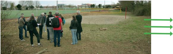
Hinter dem im Außenbereich von Drais liegenden Sportfeld besteht bereits eine Mulde, in der sich bei Regen Wasser sammelt. Mit der Fortführung eines vorhandenen Schutzwalls könnte der Abfluss nach rechts in die Gemarkung „Am Pfädchen“ verbessert und Oberflächenwasser vom Ortskern ferngehalten werden.
