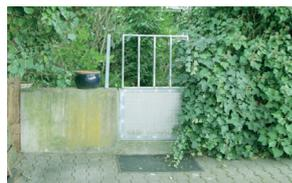
Eingänge zu Grundstücken, die an einem Tiefpunkt liegen, können mit druckdichten Türen (siehe Foto) vor eindringendem Wasser geschützt werden.
