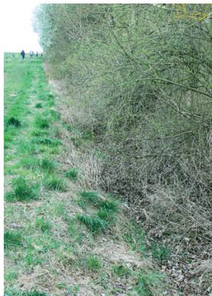
*„Die Wasserrossel“ (Bild links): Der im oberen Bereich zugeschüttete Graben und überhängender Bewuchs (Bild rechts) schränkt die Wasseraufnahme im gesamten Entwässerungsgraben ein. Kaskadenförmige Ausgrabungen würden die Fließgeschwindigkeit verringern, mehr Wasser und insbesondere Schlamm zurückhalten.*
