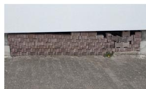
*Lose Steine vor ungeschützten Hohlräumen: Durch Ausspülung bei Starkregen entsteht eine Gefahr für Mensch und Verkehr.*
