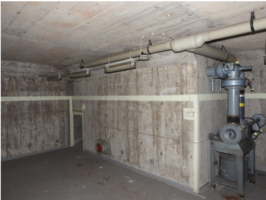
Bild 26: Weiterer Raum eines Bunkers ohne Nutzungsspuren von Fledermäusen
