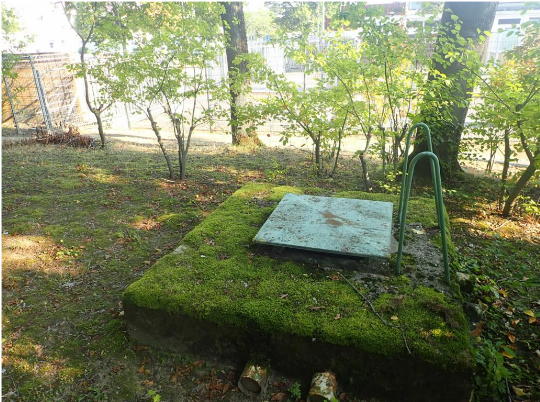
Bild 31: Das gesamte Areal ist weitläufig unterkellert bzw. mit unterirdischen Bunkeranlagen versehen
