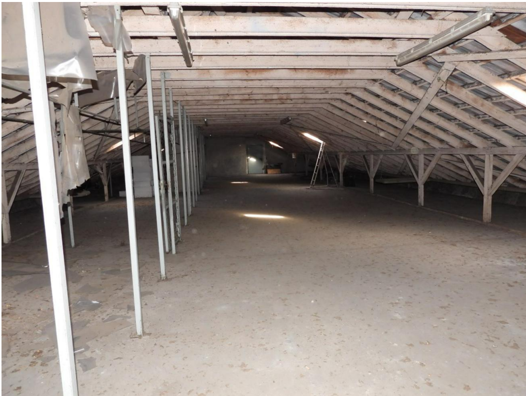
Bild 24: Beispiel eines Dachbodens ohne Nutzung durch Fledermäuse
