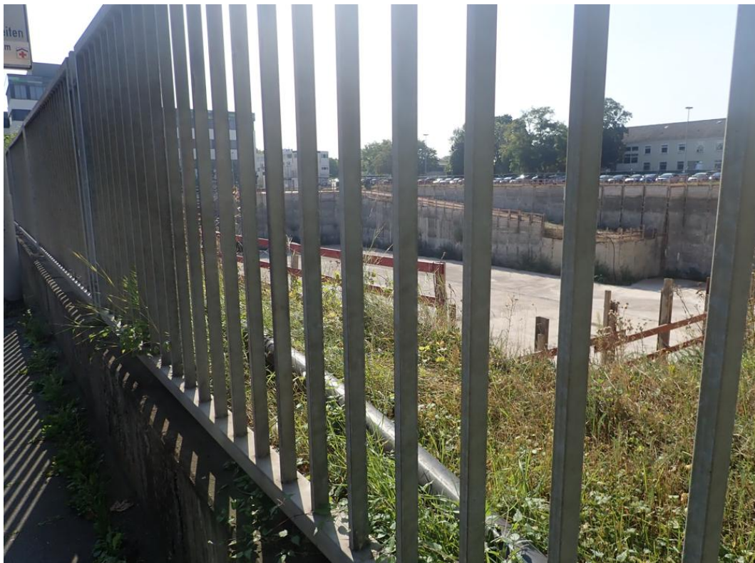
Bild 34: Die Baustelle auf dem bestehenden BioNTech SE-Gelände am Nordrand des Geltungsbereichs
