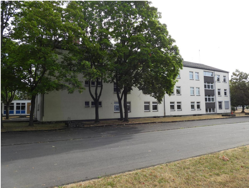
Bild 23: Blick auf eines der ehemaligen Kasernengebäude
