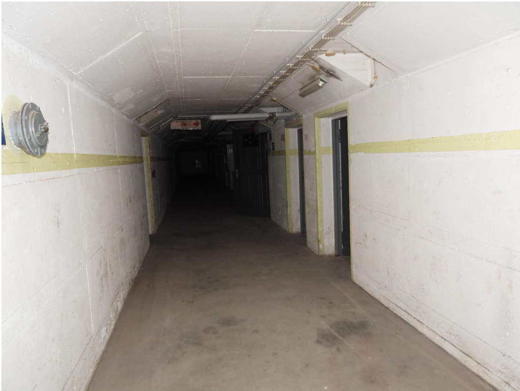
Bild 25: Beispiel eines Bunkerbereiches ohne Habitateignung für Fledermäuse
